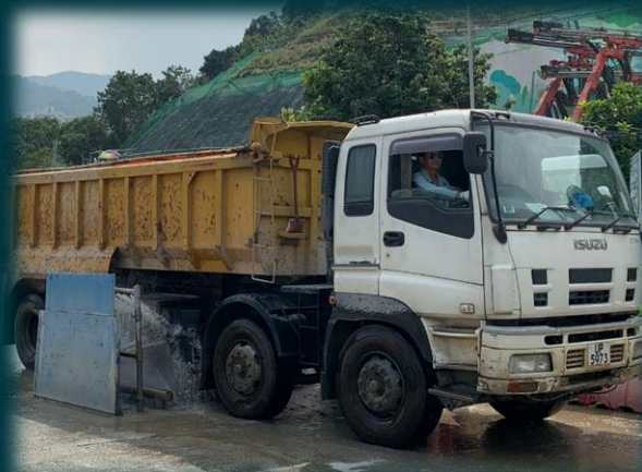
清洗車輪設施
