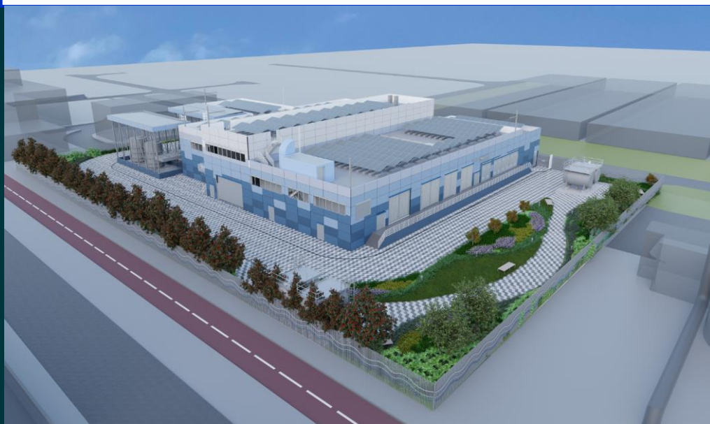
興建中途污水泵房
