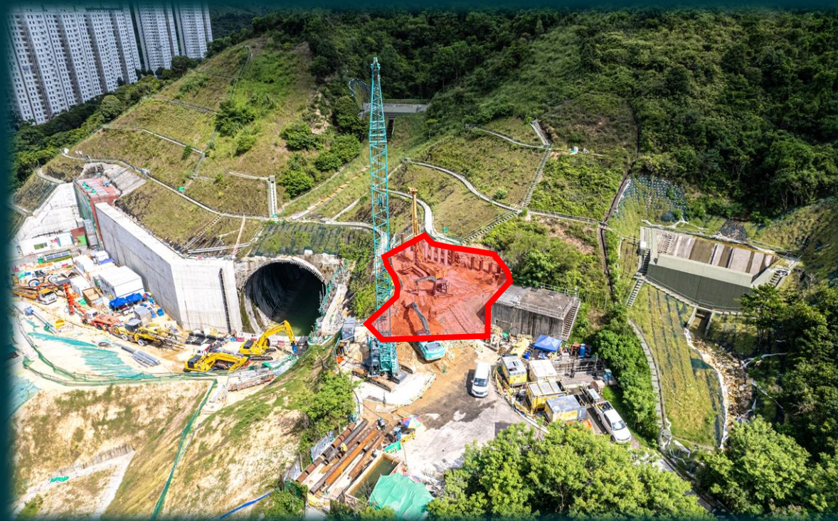
排放水輸送隧道建造工程
