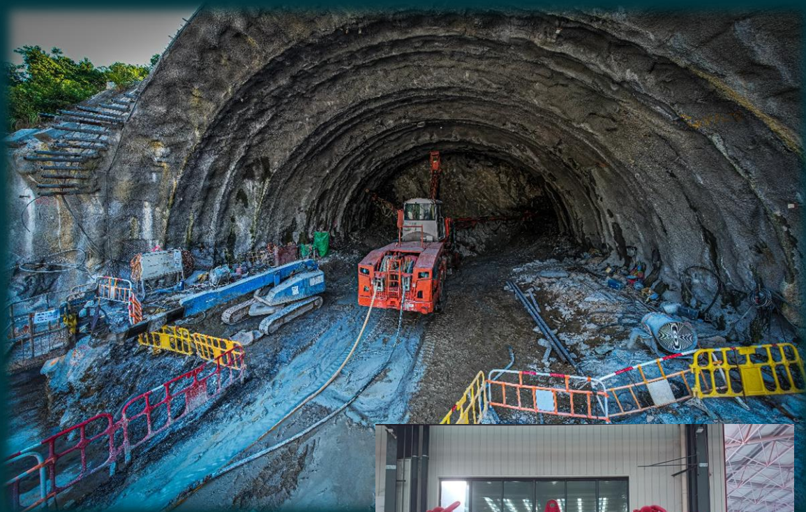
副連接隧道建造工程
