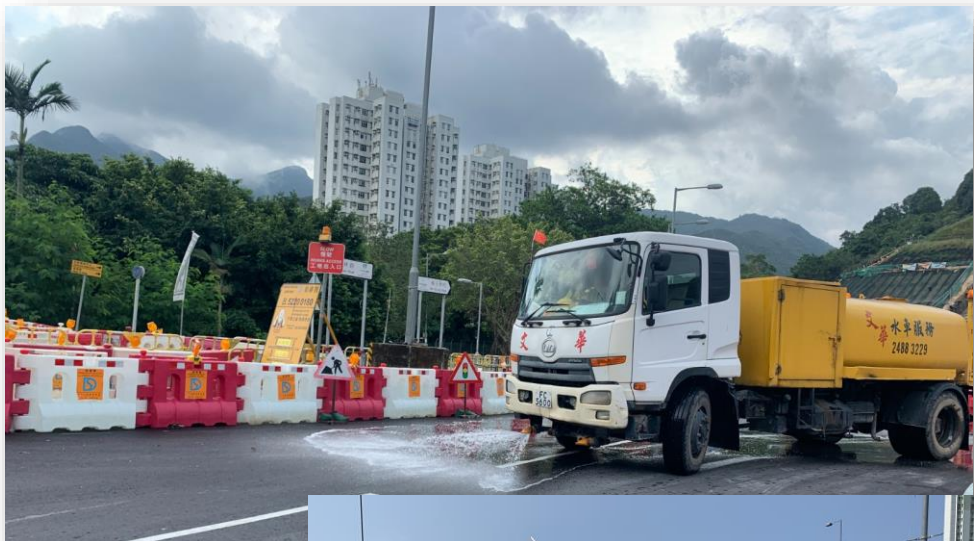
定期清洗工地路口及附近道路
