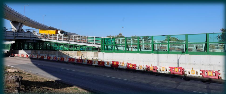
臨時隔音屏障：2021年4月完成
