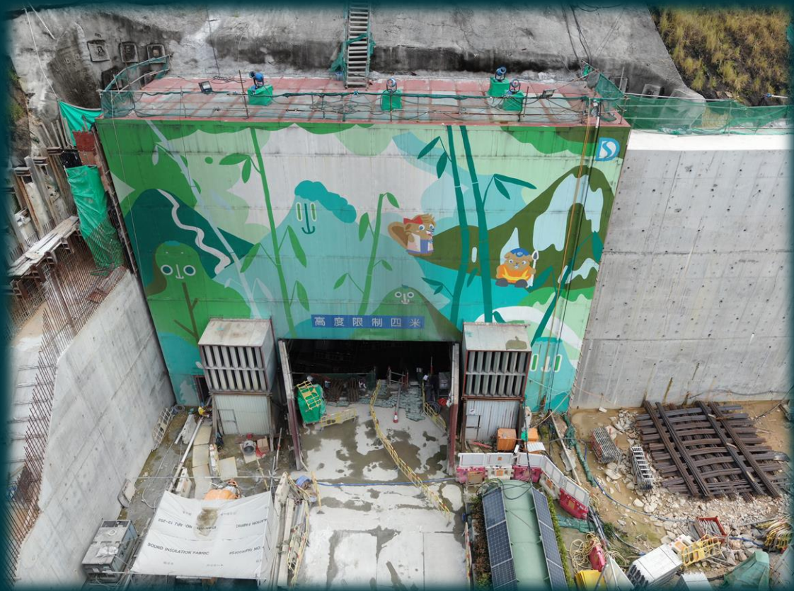
主連接隧道入口處建造工程
