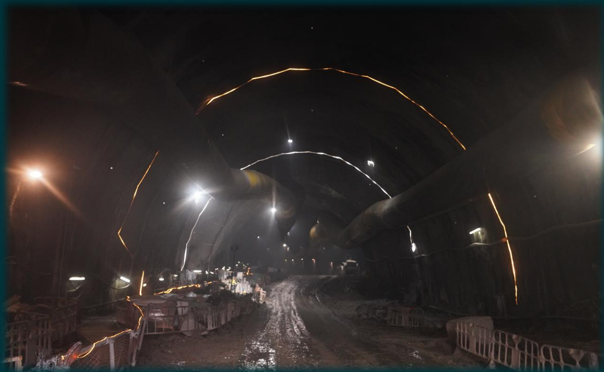
主連接隧道建造工程
