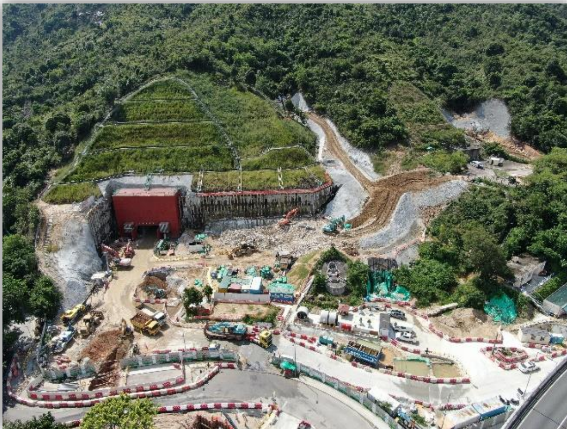
首次爆破工程於2020年9月4日順利進行
