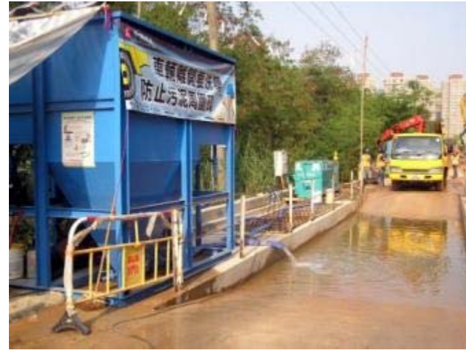
設置清洗車輪設施
