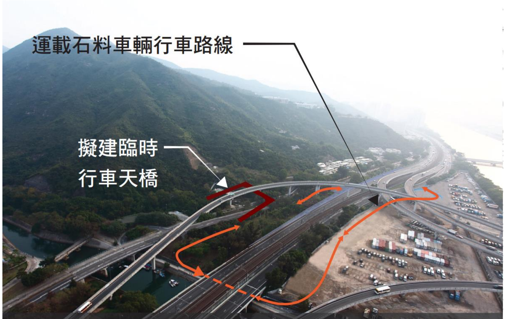
臨時工地交通管制措施 - 臨時行車天橋落成後
