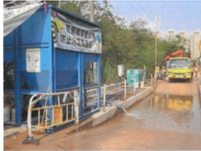
設置清洗車輪設施
