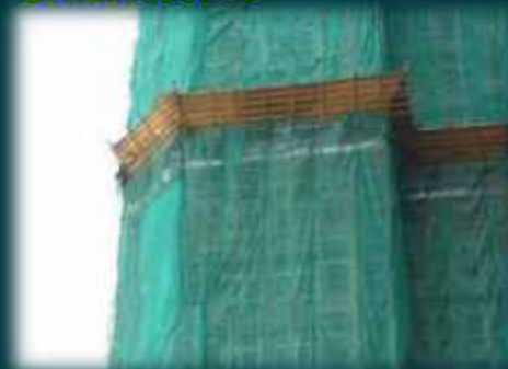
設置附安全網和防護柵的棚架
