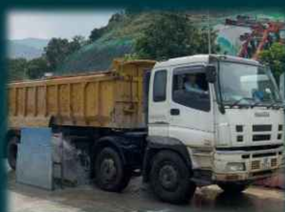
清洗車輪設施
