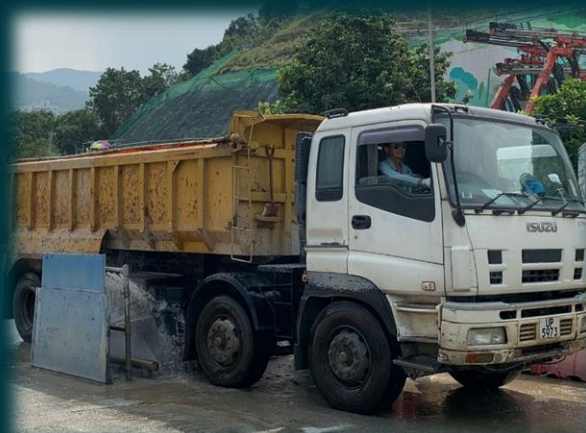
清洗車輪設施
