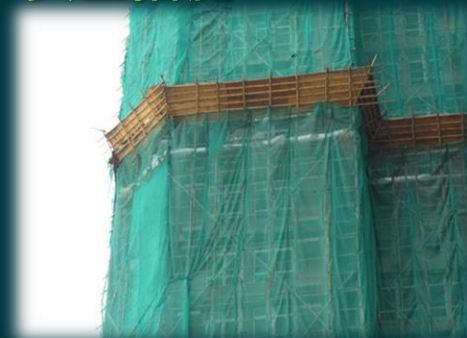
設置附安全網和防護柵的棚架
